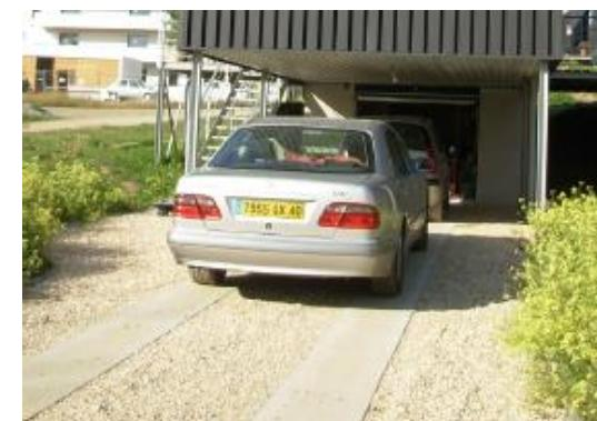
Exemples de chemin de roue béton avec abords enherbés / ou engravillonnés
